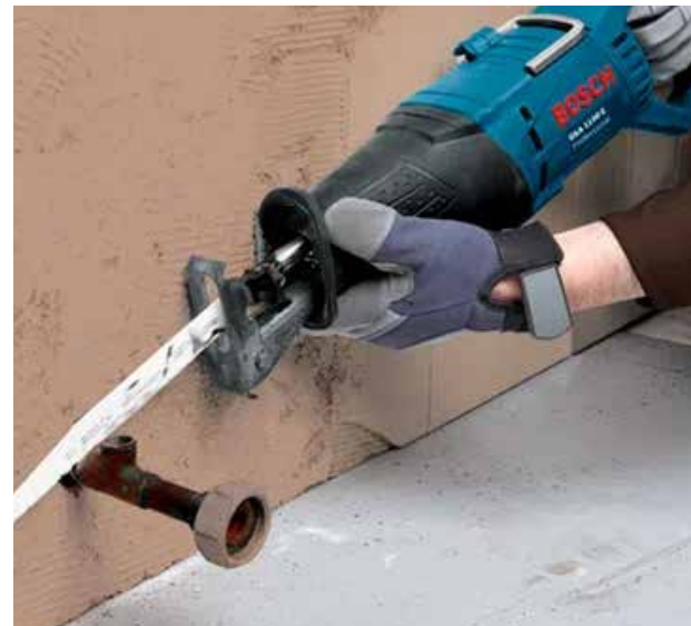
Corte de diversos materiais com lâminas apropriadas ao uso
